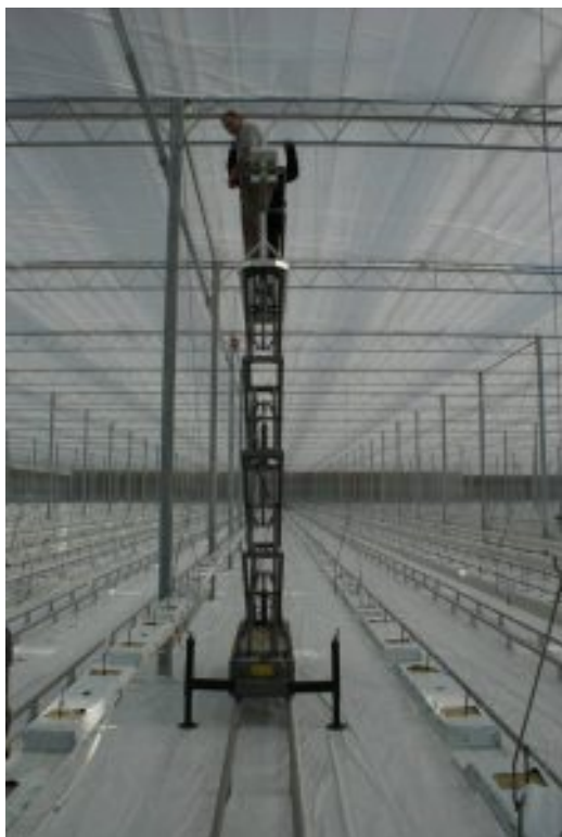
Foto: Stempel buisrailwagens af die bestemd zijn voor werkzaamheden aan het kasdek
