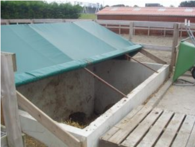
Foto: voorbeeld overdekte mestopslag
