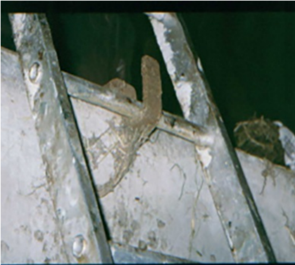
Foto: Ladder gezekerd met verdiepingshaak
